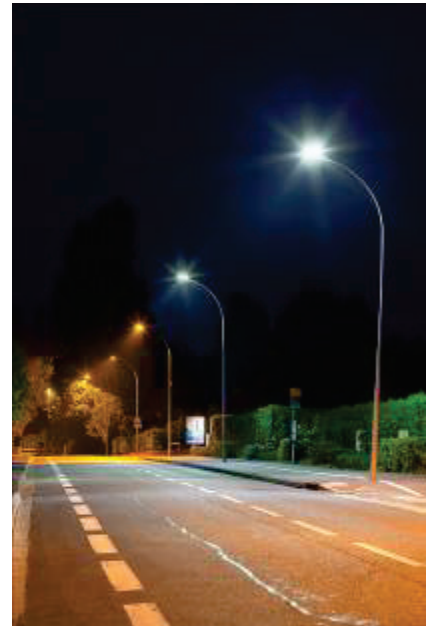
L'éclairage à LED est beaucoup plus blanc que l'éclairage existant au sodium.
