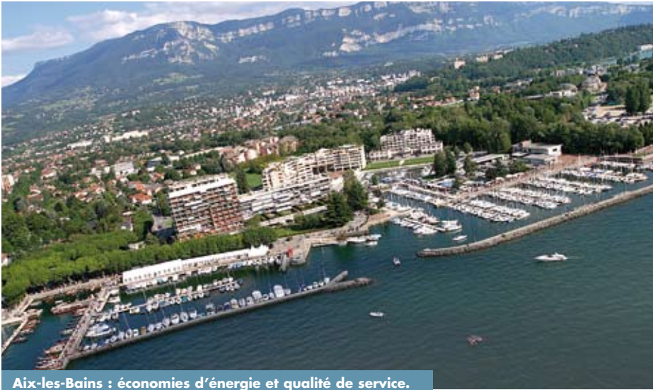
Aix-les-Bains : économies d'énergie et qualité de service.
